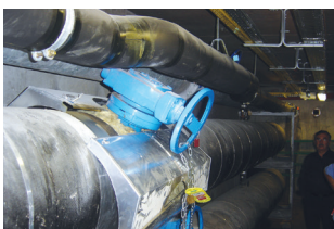
Канали з трубопроводами
