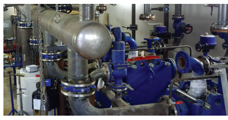
Підстанція (вхід до теплообмінника)
